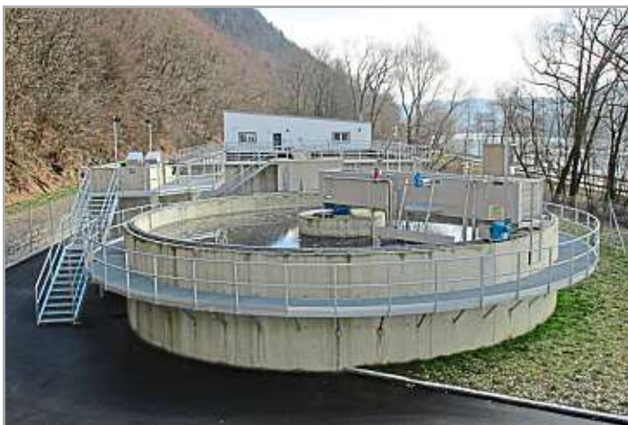
Das Nachklärbecken, mit dem zweiten, neu gebauten, Betriebsgebäude im Hintergrund. – Fotos: Franz Stangl
