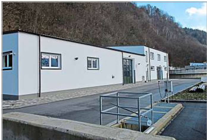
Das eine Betriebsgebäude, mit dem Nachklärbecken im rechten Hintergrund, das so wie die übrigen Gebäudeteile ebenso hochwassersicher neu gebaut wurde.
